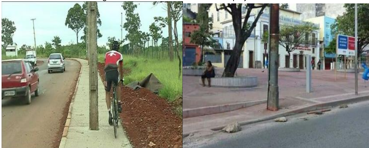
Figura 1 – Locais com acessibilidade prejudicada.
